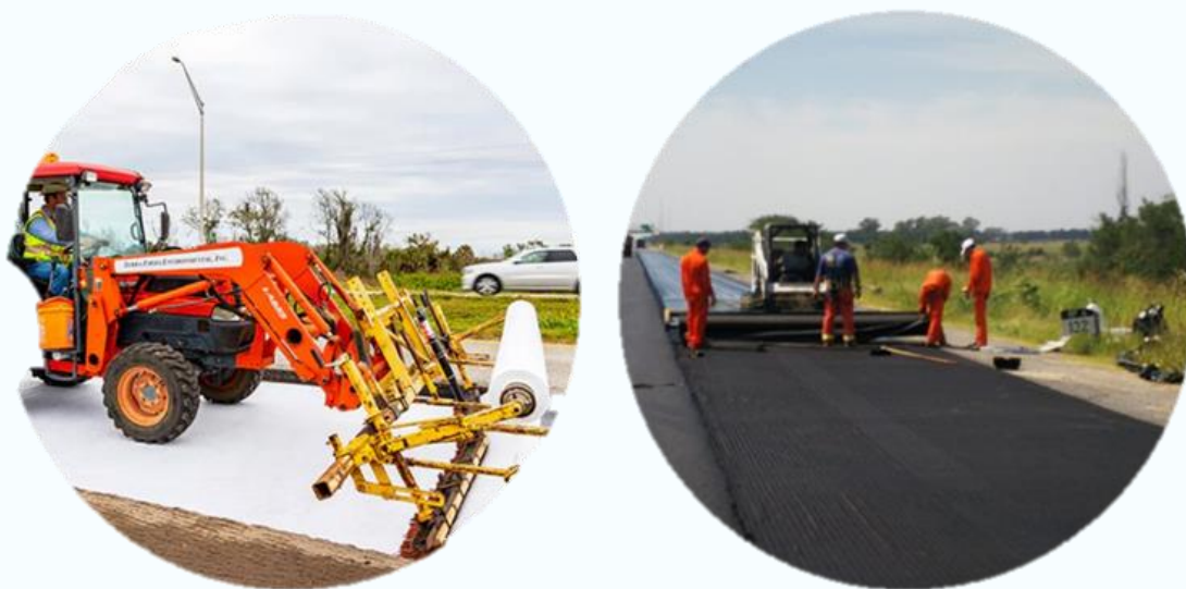
Foto 1. ejemplos de extensión mecánica de geosintéticos.
